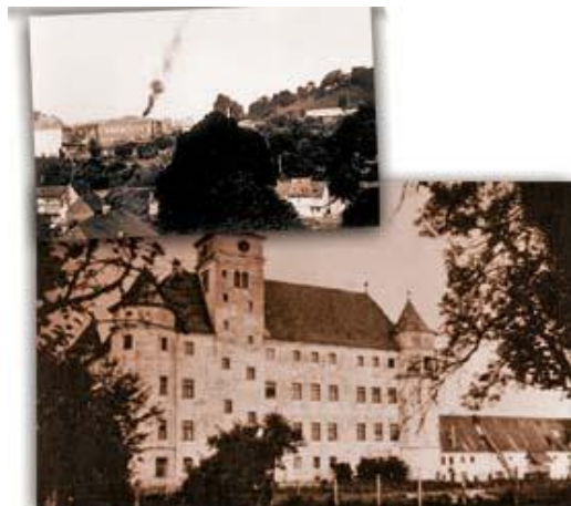
Rauchende Schloten von den Öfen, die zur Verbrennung der Körper in der NS-Tötungsanstalt Hadamar verwendet wurden.
